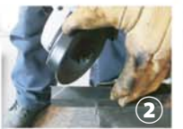
アングルやパイプは直角に繋ぎたいときは、両端を斜め45度にカットしよう(写真①②③)。
